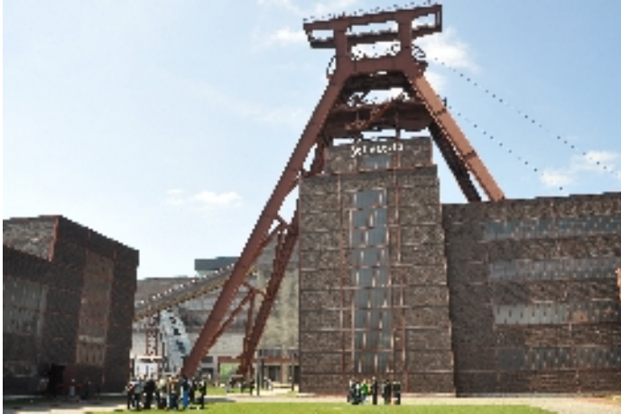
Doppelbockfördergerüst „Zeche Zollverein Schacht XII .....
