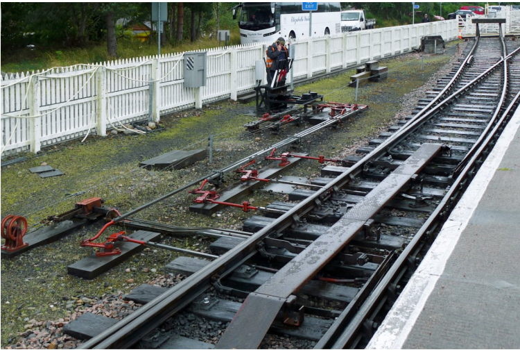
Schutzweiche am Anschlussgleis zur Hauptbahn (rechts) und Umfahr-Weiche (links angeschnitten). Man beachte die rustikale offenliegende Mechanik der Hand-Antriebe. Auch mit Seilzügen stellbar!
