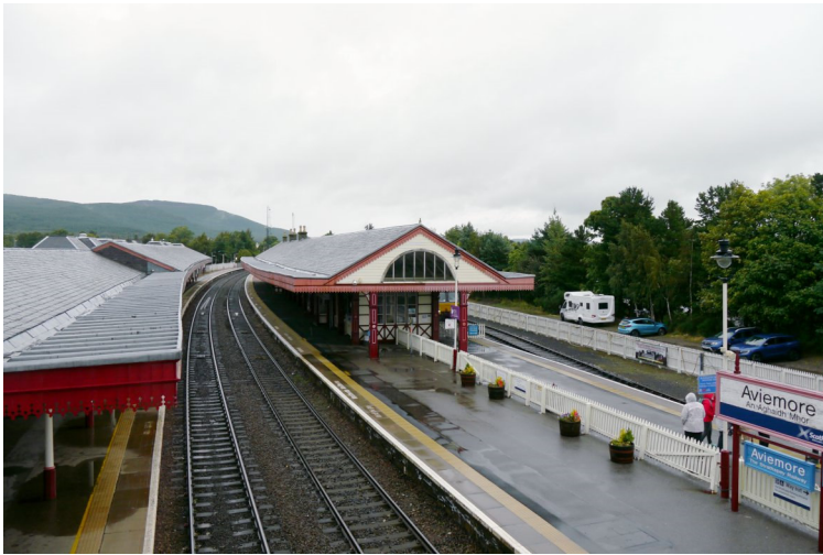
Bf Aviemore, links die Hauptstrecke, rechts das Bahnsteiggleis der Museumsbahn. Der Bahnsteig der früheren Strathspey-Linie lag etwas abseits. Als wir ankamen, war gerade kein Zug in Sicht.
