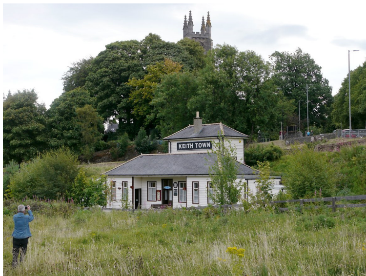
Hochbau am Hp Keith Town unterhalb der Stadt, noch verschlossen
